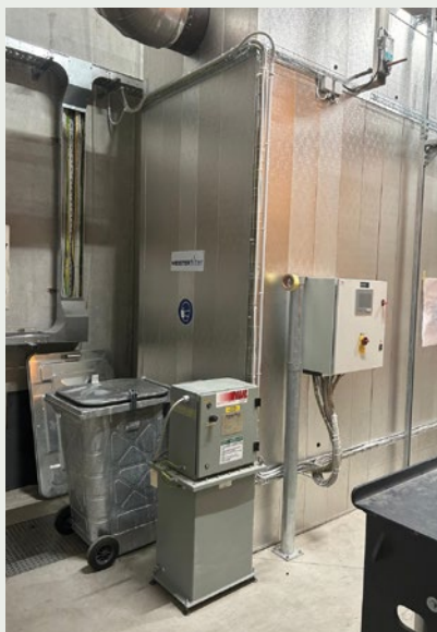
Filtro elettrostatico
