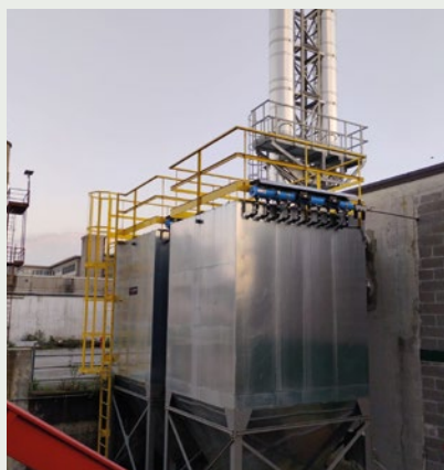
Filtro elettrostatico
