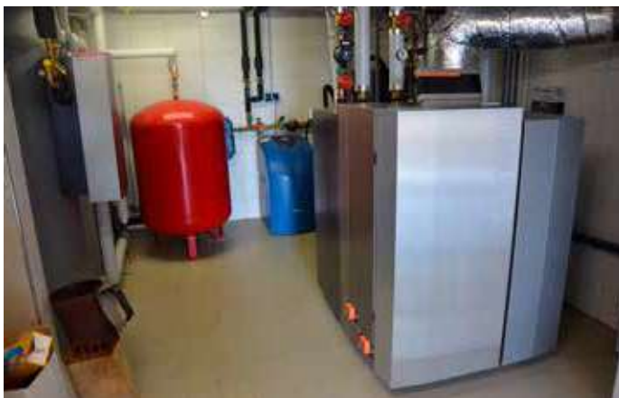
Sistema ibrido BMK30-PdC16. A sinistra (foto 2) il locale tecnico con il modulo caldaia e PdC; a destra (foto 3) l'unità esterna della PdC aria-acqua (evaporatore)
