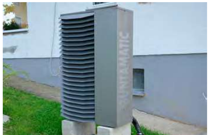
Sistema ibrido BMK30-PdC16. A sinistra (foto 2) il locale tecnico con il modulo caldaia e PdC; a destra (foto 3) l'unità esterna della PdC aria-acqua (evaporatore)
