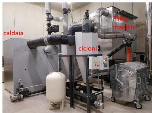
**Caldaia 880 kW a cippato (Albergo)**
