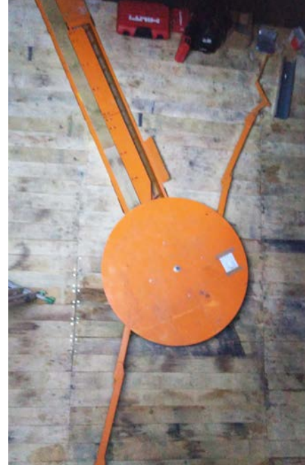
L'interno del vano cippato con rotore a balestre
