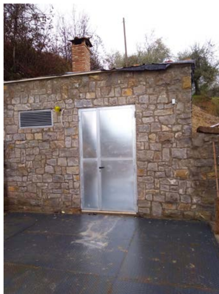
La centrale è staccata dall'edificio principale ed è stata realizzata a ridosso di una scarpata
