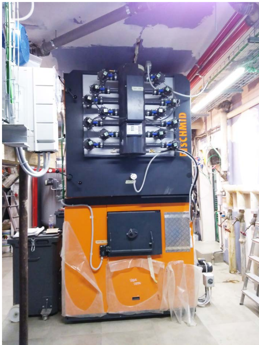
La caldaia Schmid UTSK 900 2.3 in fase finale di installazione
