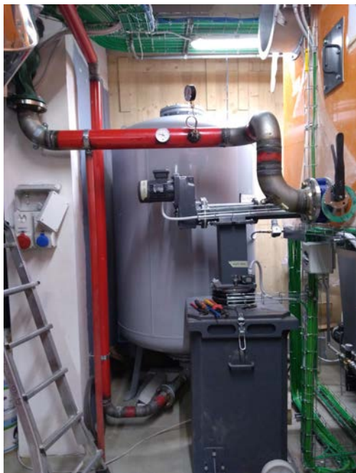
La caldaia Schmid UTSK 900 2.3 in fase finale di installazione
