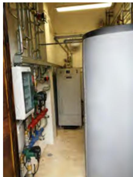
L'interno della centrale con la caldaia Herz Pelletmatic e il puffer
