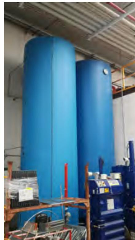
I due accumuli termici, per una capacità di 28.000 l.
