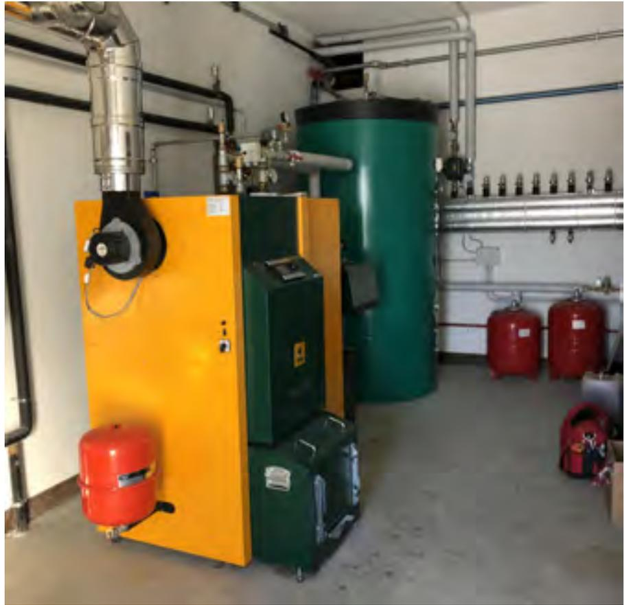
*La caldaia KWB Pelletfire Plus PFP 75 RS e il puffer di accumulazione*
