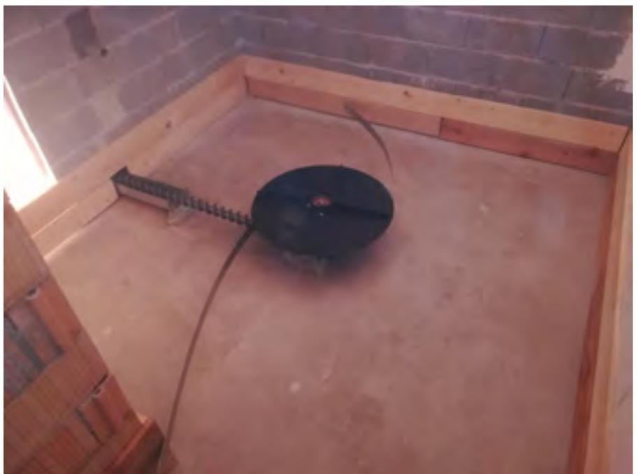
*Deposito del pellet in fase di realizzazione dotato di coclea e agitatore a balestre*
