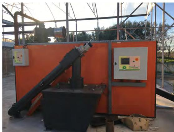
grado di garantire un'elevata efficienza e una combustione completa del materiale. L'estrazione del combustibile dal deposito avviene tramite un sistema dotato di braccio articolato e coclea di estrazione.
