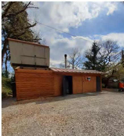
La centrale termica con la falda del tetto ad apertura idraulica manuale per il rifornimento del cippato
