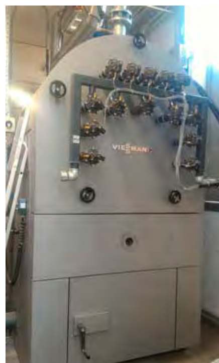
La caldaia Viessmann Vitoflex 300 FFU da 700 kW
