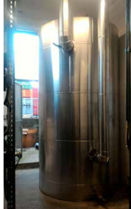
Il puffier da 8.000 litri assemblato sul posto
