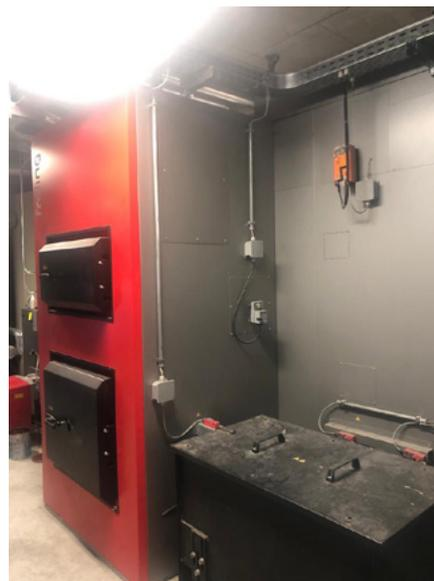
*La coclea di alimentazione della caldaia*
