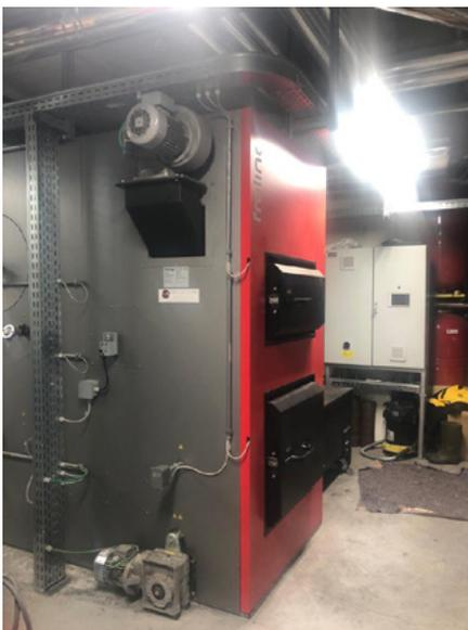
*La caldaia dal lato del serbatoio di raccolta automatica delle ceneri*
